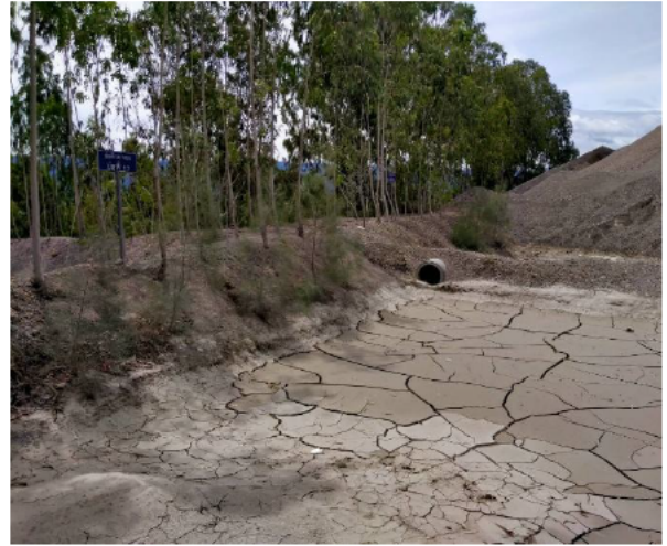
รูปที่ 2-9 บ่อดักตะกอนเพื่อรองรับรับชะล้างตามแนวเขต ในพื้นที่เวนการทำเหมืองในระยะ 10 เมตร รอบพื้นที่ประทานบัตรตามที่แผนผังโครงการกำหนด
