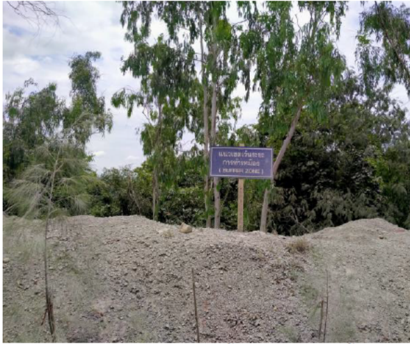
รูปที่ 2-8 ดินทำนบดิน คุระบายน้ำตามแนวเขตในพื้นที่เวน การทำเหมือง ในระยะ 10 เมตร
