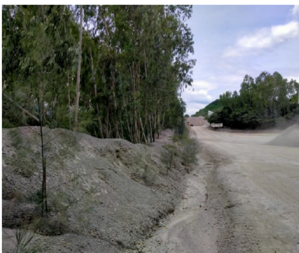
รูปที่ 2-7 ค้นทำนบดิน ร่องระบายน้ำ บริเวณจุดเก็บกองเปลือกดิน และเศษหินชั่วคราว
