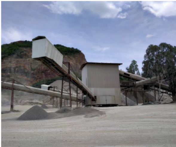
รูปที่ 2-17 โรงโม่หินของโครงการมีการจัดทำเป็นระบบปิด
