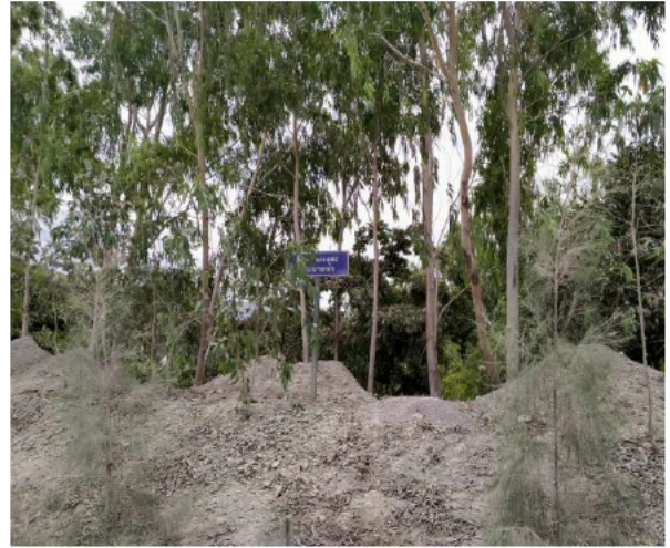
รูปที่ 2-20 (ต่อ) แนวต้นไม้บนคันทำนบดินเพื่อเป็นแนวกัน ชนป้องกันฝุ่นละอองแพร่กระจายออกสู่ภายนอก
